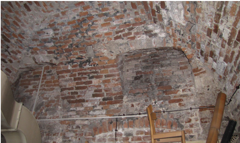
4. Piwnice z czasów Władysława IV pod częścią południową Pałacu Kazimierzowskiego, widok na zamurowane okna w zewnętrznej ścianie od dziedzińca, 2015. Fot. T. Bernatowicz / Cellars from the time of Ladislas IV under the southern part of the Kazimierzowski Palace, view of the bricked up windows in the outer wall on the side of the courtyard, 2015. Photo T. Bernatowicz
