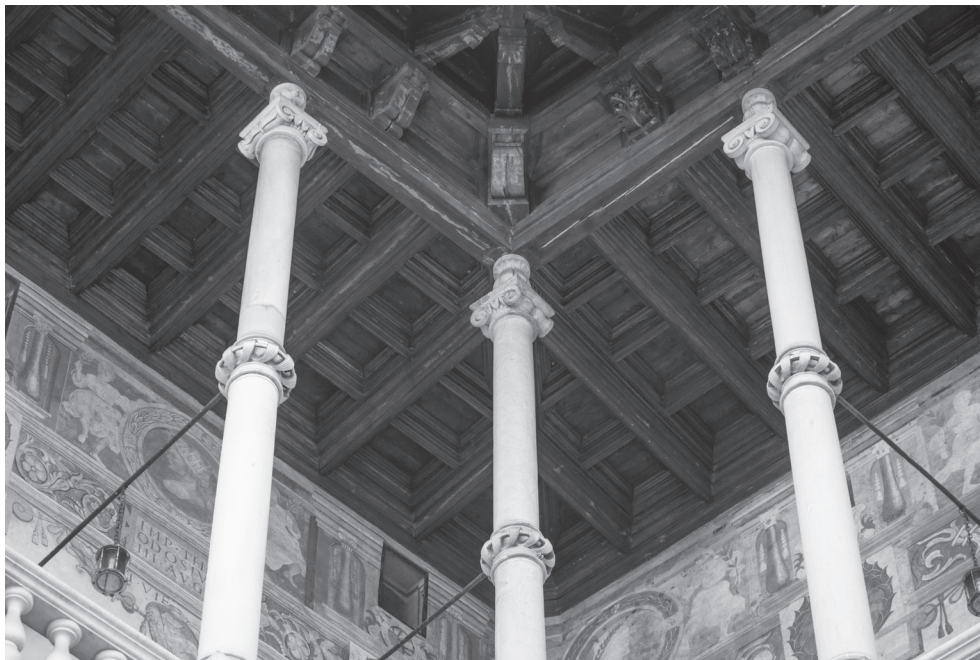
4. Kraków, Zamek Królewski na Wawelu, kolumny loggii na II piętrze, narożnik skrzydła wschodniego i południowej ściany parawanowej
