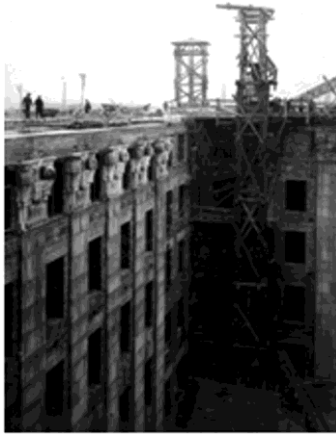
Ryc. 3. Fragment elewacji północnej w trakcie budowy gmachu, 1926 r. Fotografia archiwalna ze zbiorów Śląskiego Centrum Dziedzictwa Kulturowego w Katowicach.
