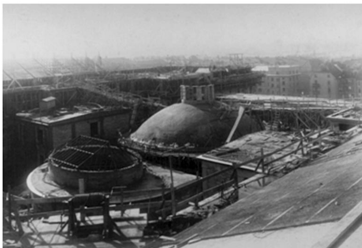
Ryc. 4. Kopia nad westybulem i świetlik nad salą sejmową, 1926 r. Fotografia archiwalna ze zbiorów Śląskiego Centrum Dziedzictwa Kulturowego w Katowicach.
