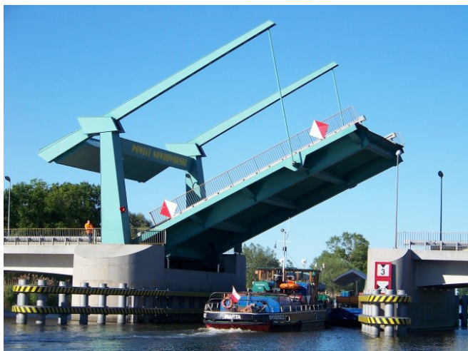
Fot. 5. Most zwodzony na Szkarprawie, Drewnica
